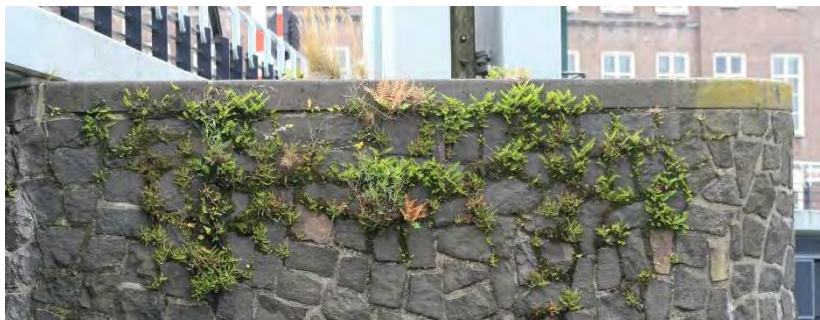
Steenbreekvaren en Gewone eikvaren op brugpijler Katenburgerbrug 2008
